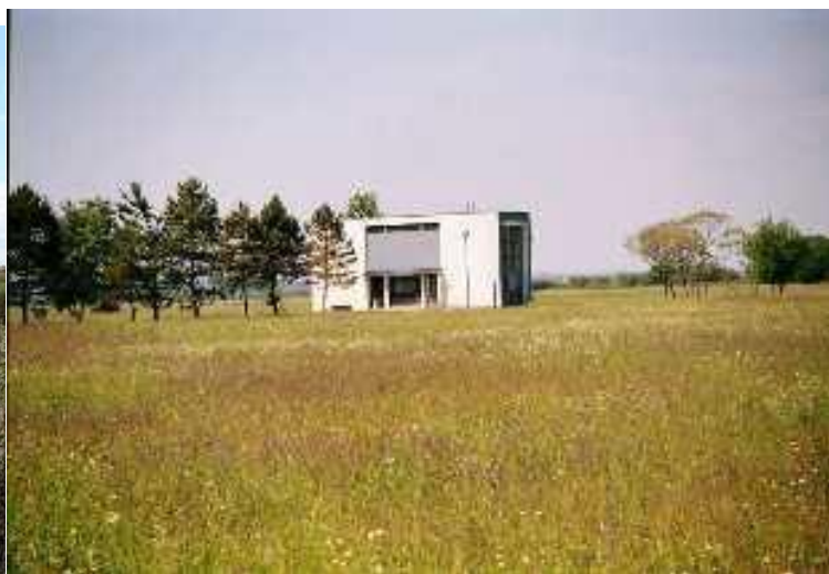
Zagrebačko crpilište Mala Mlaka s 10 kopanih zdenaca promjera 6 m dubine 13 m do 18 m + 6 bušenih do 40 m
