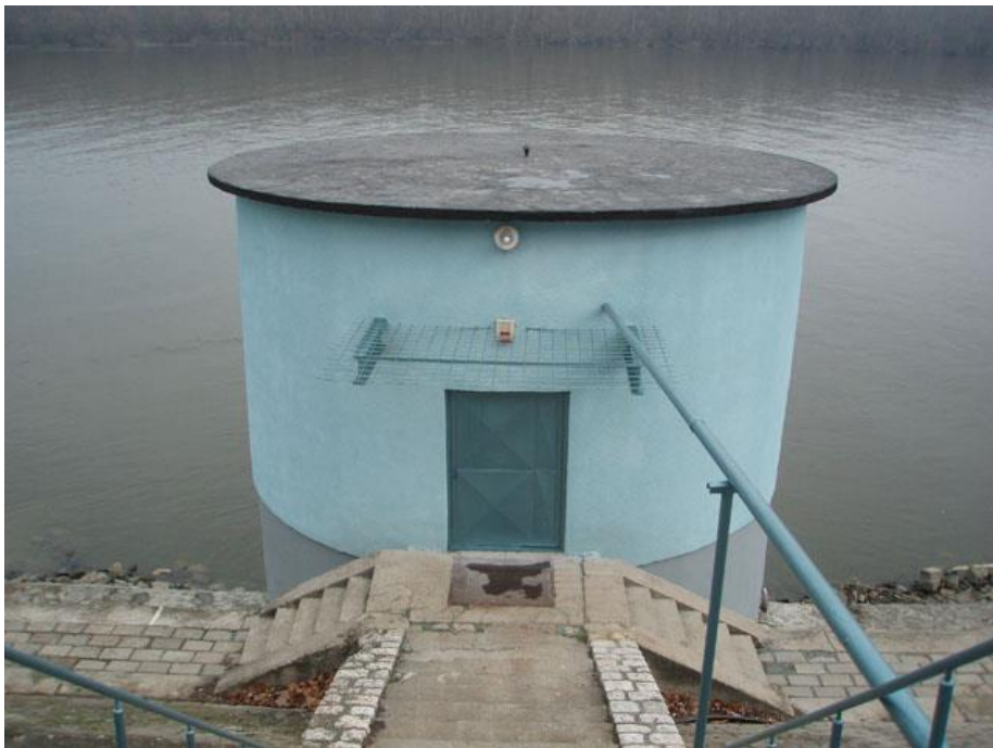
Vodozahvat na Dunavu, Vukovarski vodovod
