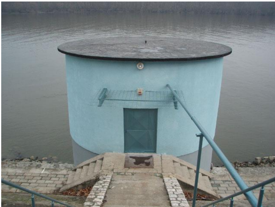
Vodozahvat na Dunavu, Vukovarski vodovod
