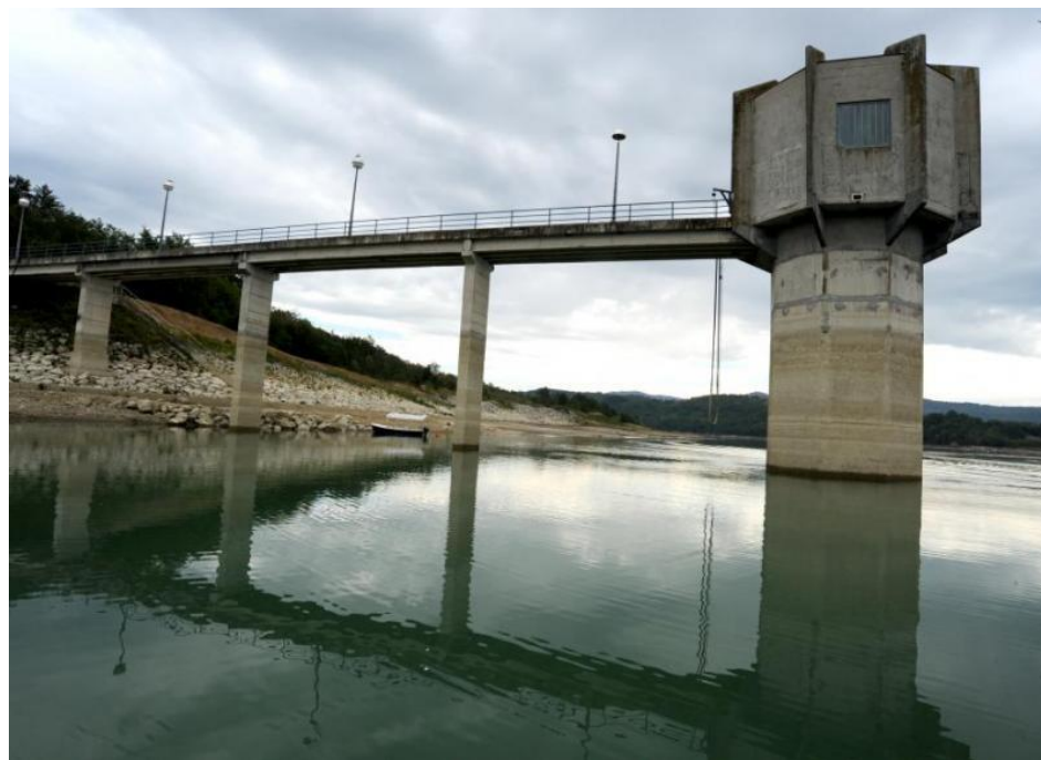
Vodozahvat na Butonigi, vodoopkrbni sustav Istre
