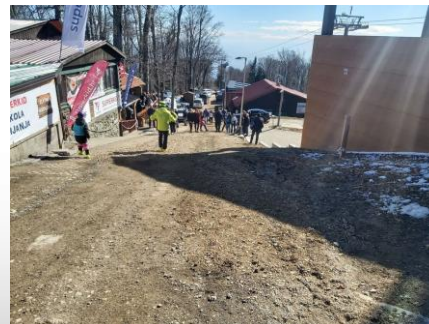
Stanje vrha nakon gradnje žičare
