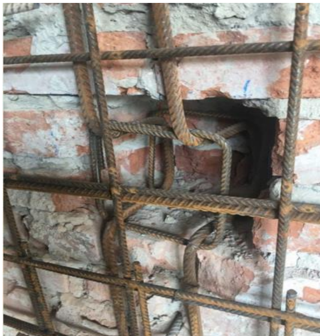
Slika 35: Način postavljanja posmičnih trnova - primjer s gradilišta
