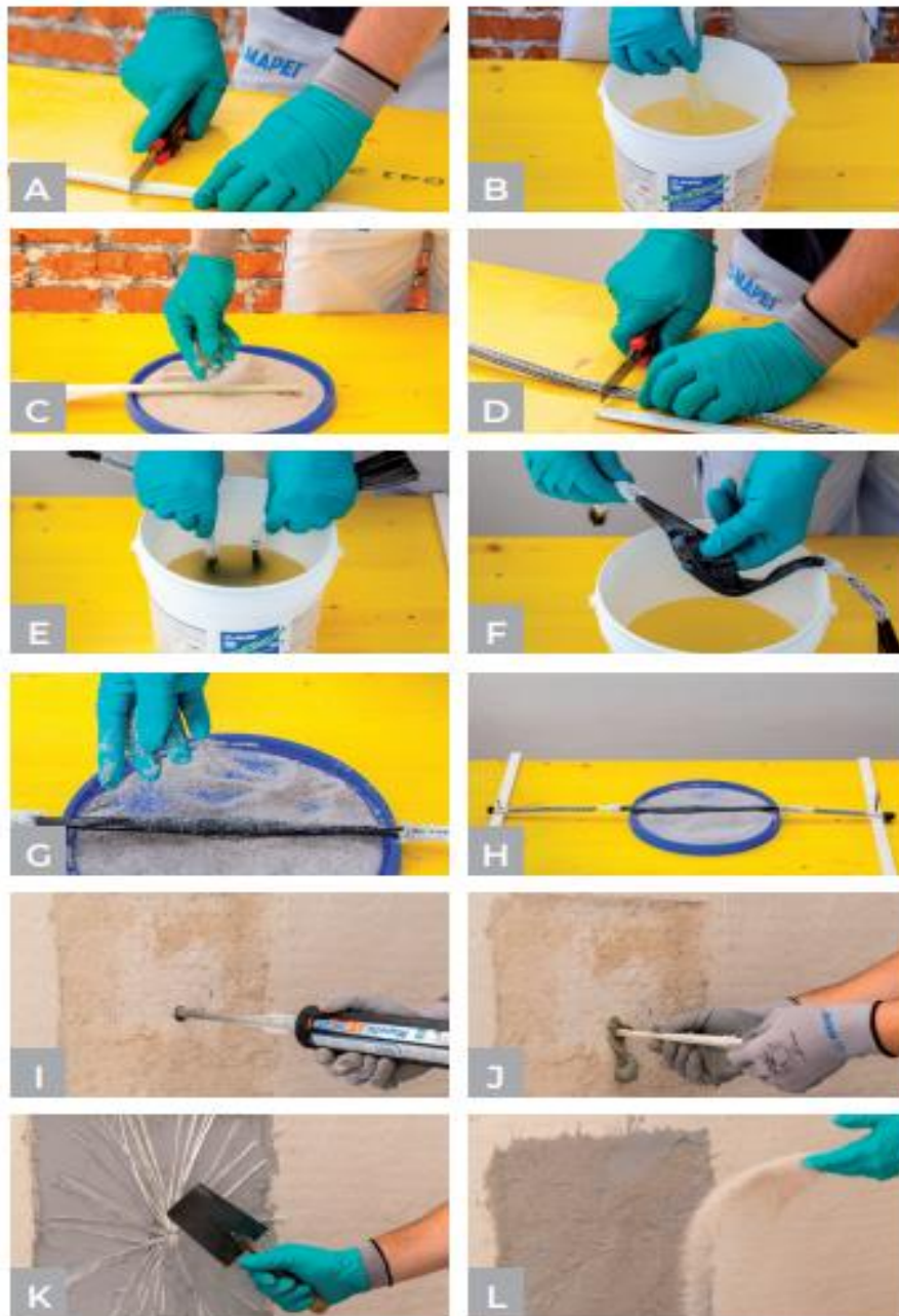
Slika 31 Detalji izvedbe ojačanja sidrima kod jednostranog ojačanja
