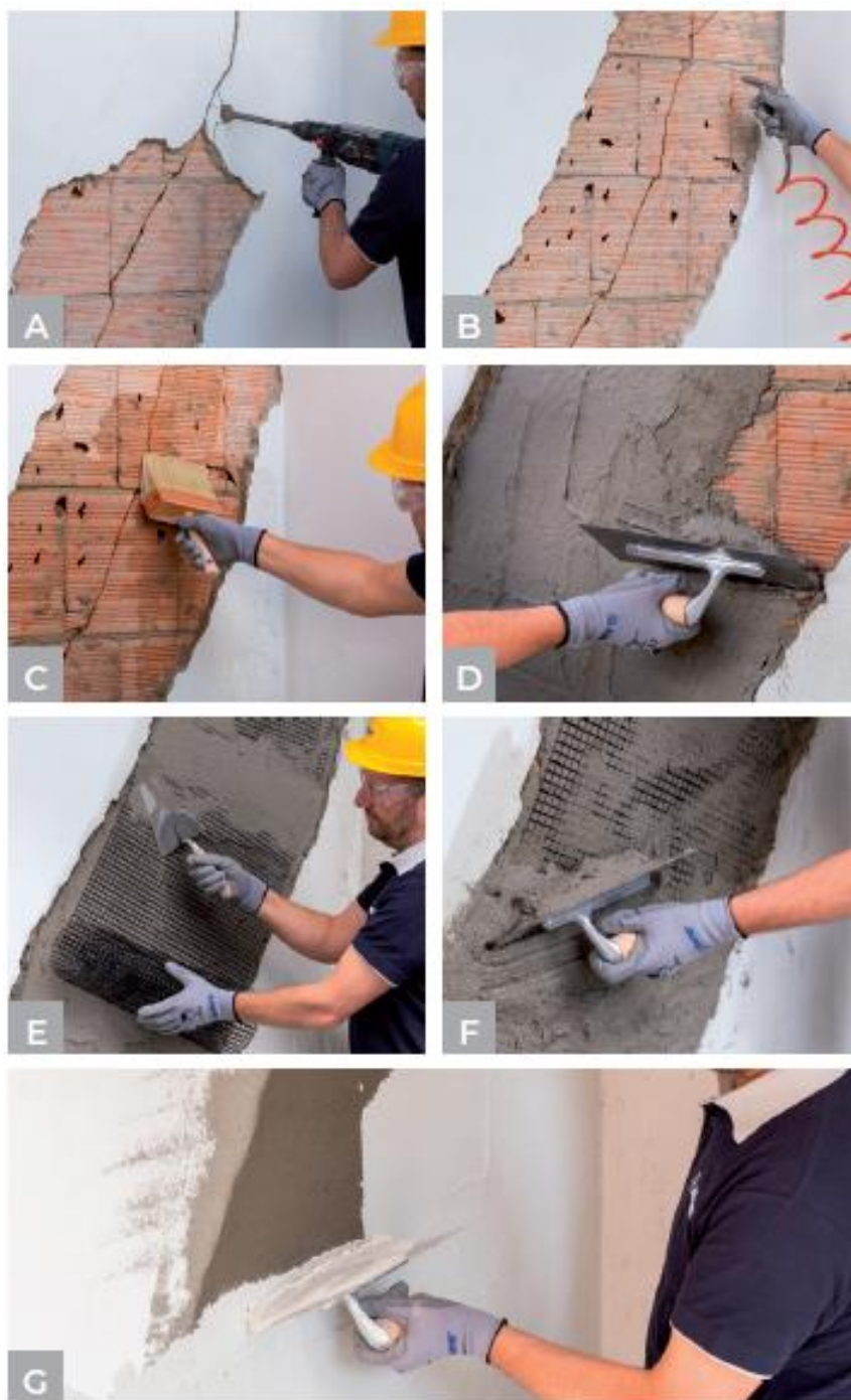
Slika 28 Postupak izvedbe ojačanja FRCM sustavom - praktični dio
