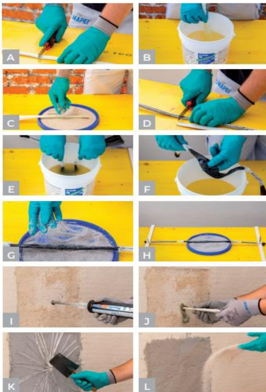
Slika 26 Detalji izvedbe ojačanja sidrima kod jednostranog ojačanja
