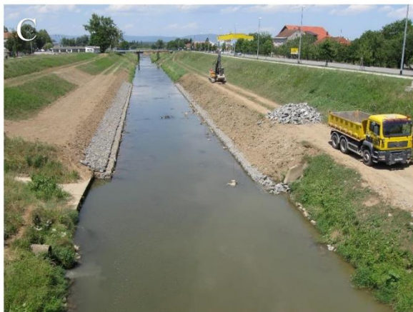
Sl. 2.9. Ljudski utjecaji na morfologiju korita: A) obaloutvrda od kamenog nabačaja, B) stepenica u Pleternici, C) kanalizirano korito u Pleternici, D) stepenica nizvodno od Bečića
