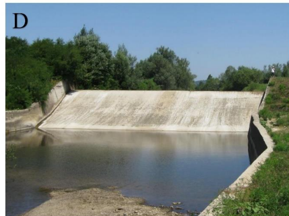
Sl. 2.9. Ljudski utjecaji na morfologiju korita: A) obaloutvrda od kamenog nabačaja, B) stepenica u Pleternici, C) kanalizirano korito u Pleternici, D) stepenica nizvodno od Bečića
