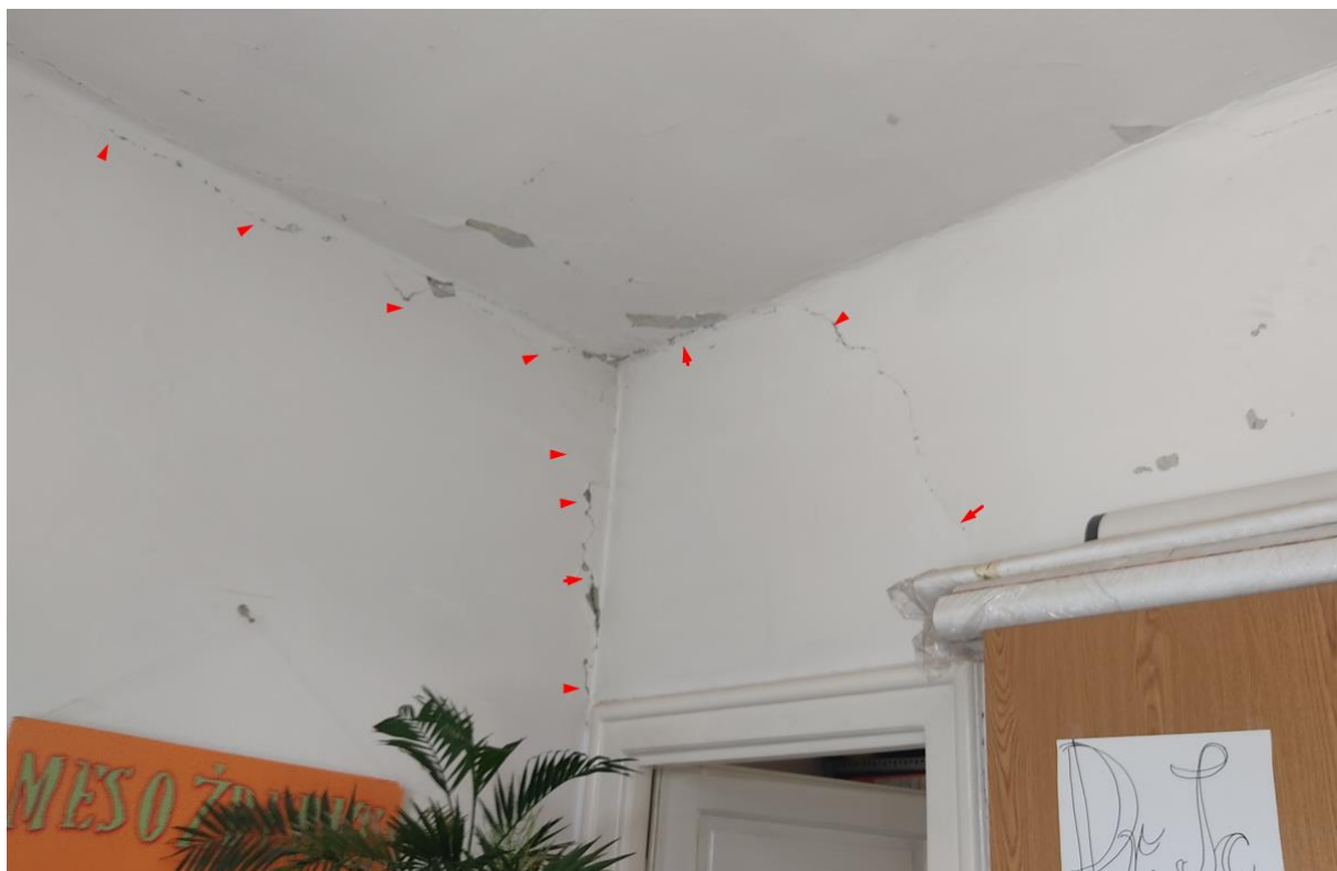
Slika 47 Pukotine na zidu na 1. katu – Pozicija 40
