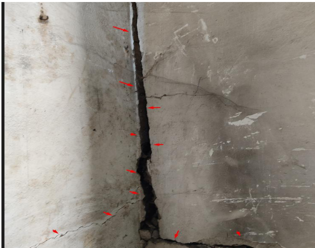
Slika 29 Pukotine na AB zidu u ostavi – Pozicija 20
