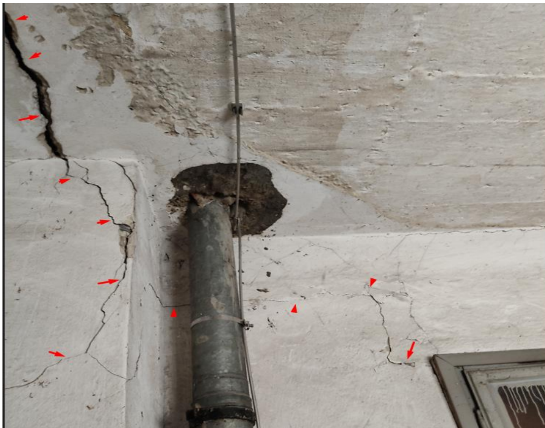
Slika 28 Pukotine na AB zidu u ostavi – Pozicija 18
