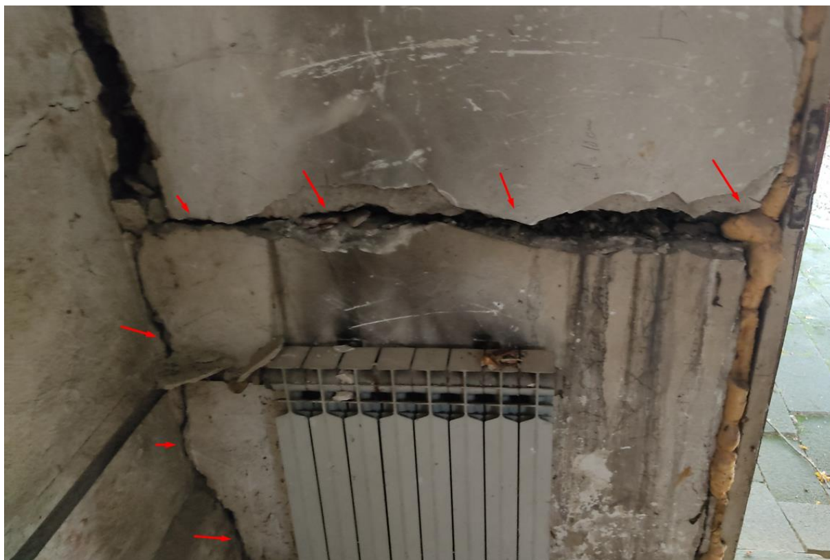
Slika 30 Pukotine na AB zidu u ostavi – Pozicija 21
