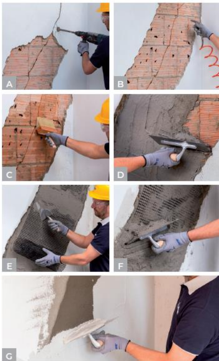
Slika 83 Postupak izvedbe ojačanja FRCM sustavom - praktični dio
