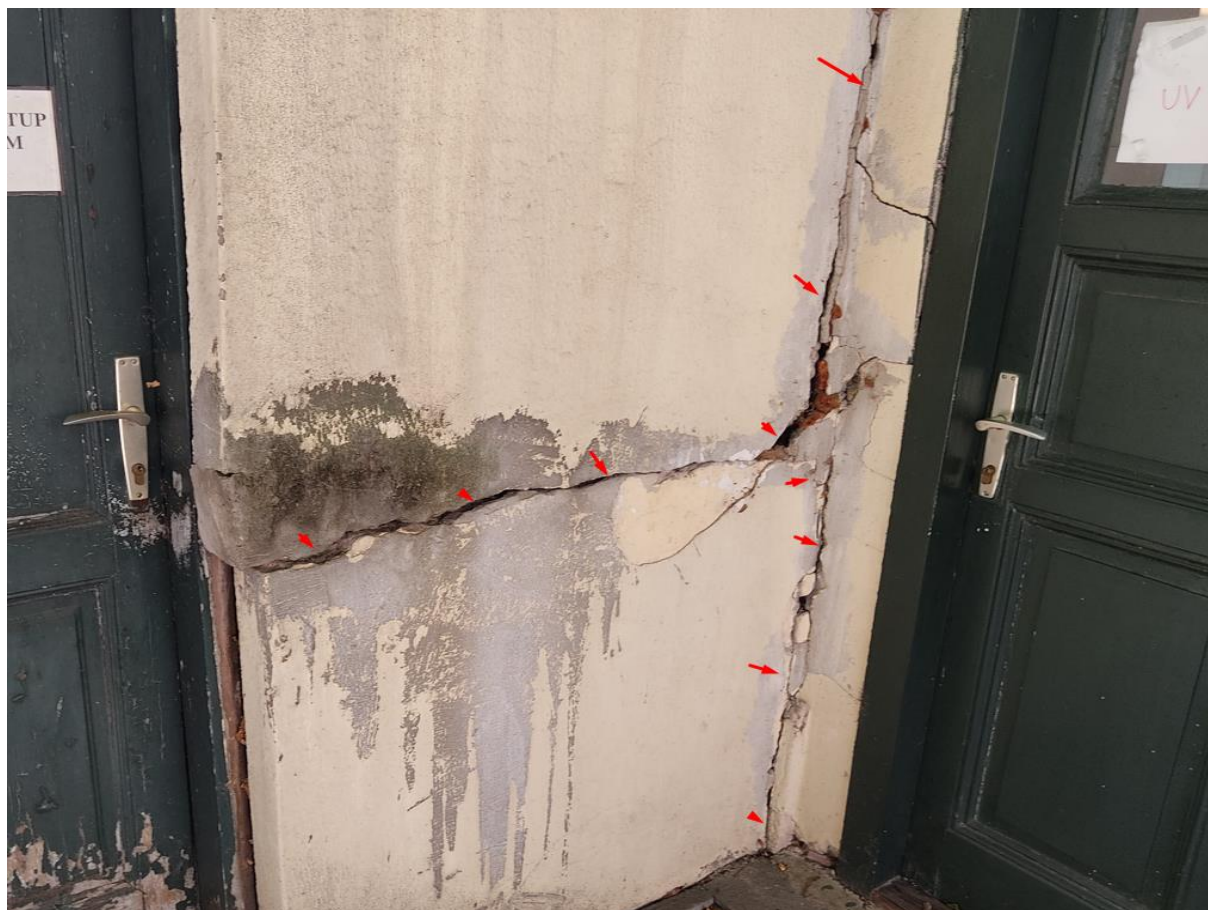
Slika 24 Pukotine na zidu– zapadno pročelje – Pozicija 15
