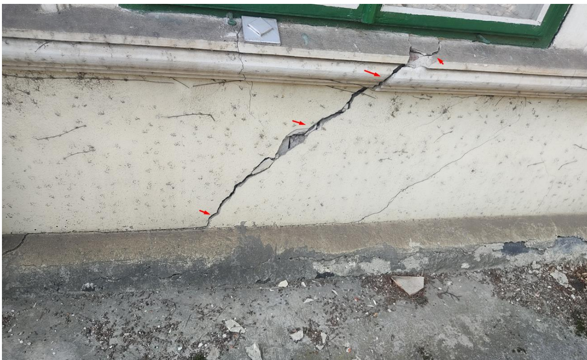
Slika 43 Pukotine na parapetnom zidu na 1. katu – Pozicija 36
