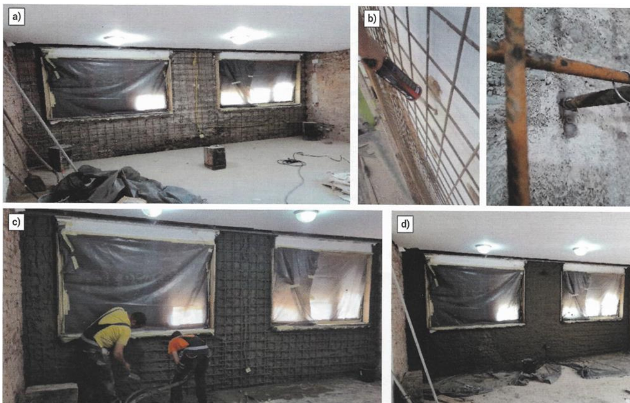
Slika 91: Praktični dio izvođenja radova torkretiranja u etapama: a) postavljanja armatura; b) sidrenje i povezivanje Q mrežom; c) prvi sloj torkreta; d) drugi sloj torkreta.
