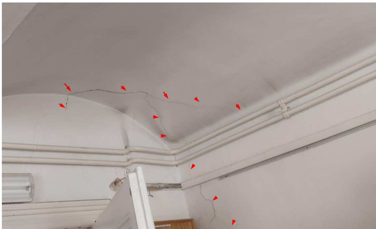
Slika 34 Pukotine na AB zidu u ostavi – Pozicija 25
