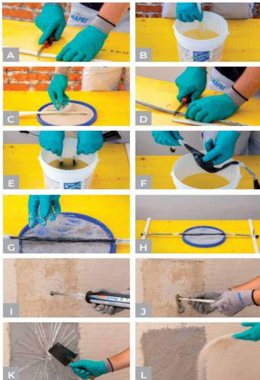
Slika 86 Detalji izvedbe ojačanja sidrima kod jednostranog ojačanja
