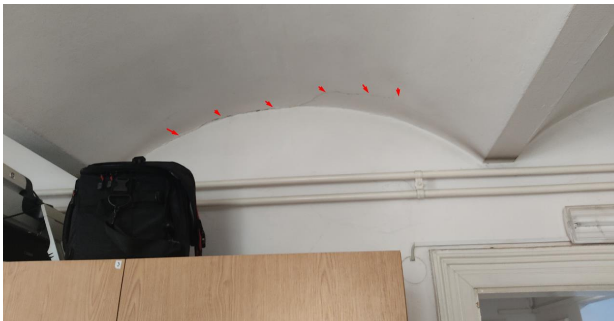
Slika 33 Pukotine na završnim slojevima međukatne konstrukcije – Pozicija 24
