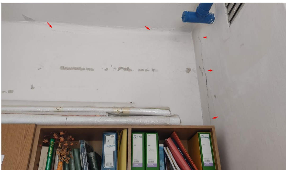
Slika 46 Pukotine na zidu na 1. katu – Pozicija 39
